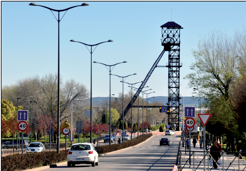
Rys. 5.27. Pogórniczne miasto Puertollano – 39 m wieża szybowa na Rondzie Avenida de Ciudad Real
