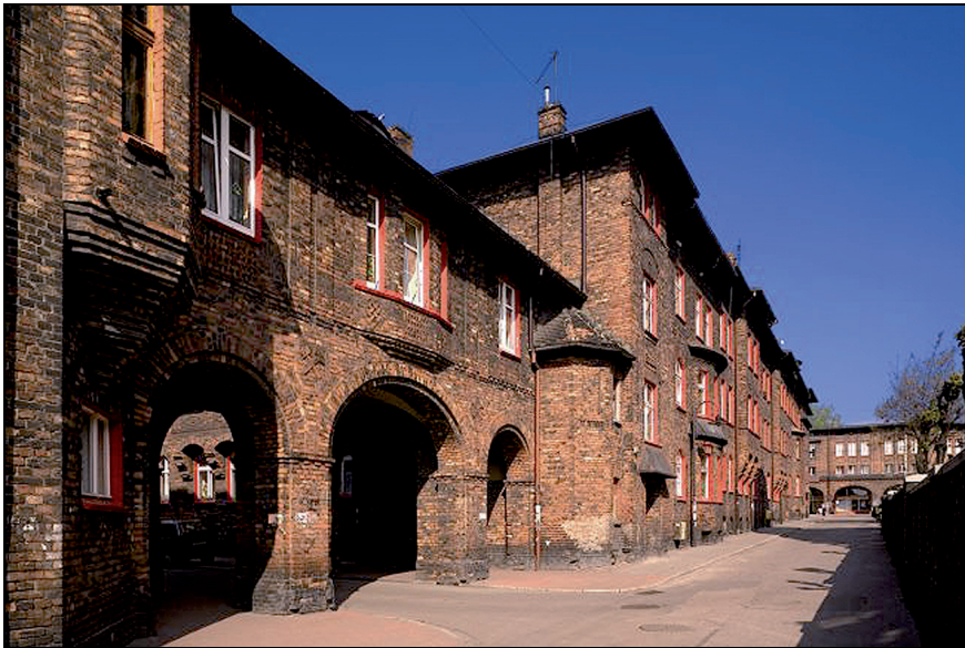
Rys. 4.16. Osiedle Nikiszowiec w Katowicach
