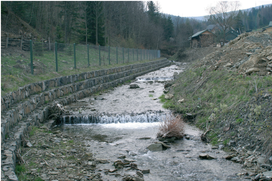
Fot. 13. Przebudowane koryto Łosiańskiego Potoku (fot. A. Kicińska, 2006 r.)
