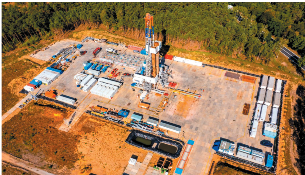
Rys. 5. Usytuowanie urządzenia Bentec 2000 HP wraz z zapleczem na padzie powierzchniowym
