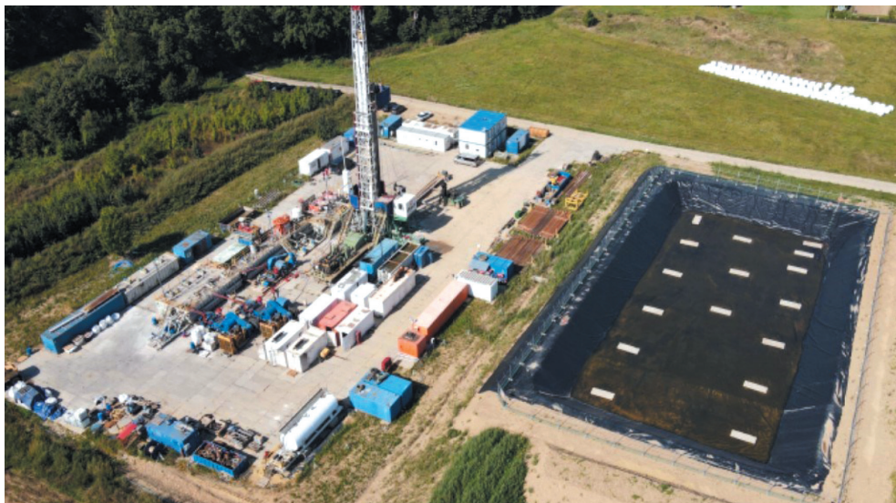
Rys. 7. Usytuowanie urządzenia Drillmec MR8000 wraz z zapleczem na padzie powierzchniowym
