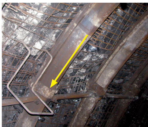
Rys. 4.30. Deformacje konturu chodnika Cw-1 badawczego: a) zmiana przekroju poprzecznego wyrobiska, b) zsuw na zamkach obudowy – ocios lewy
