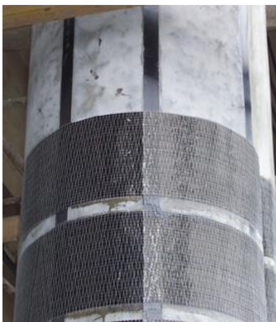
Rysunek 17. Wzmocnienie istniejącej kolumny betonowej.
