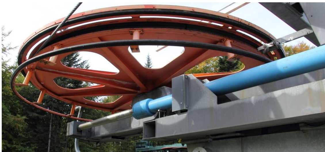
Rys.IV.5. Koło przewojowe wraz z układem napinania.
