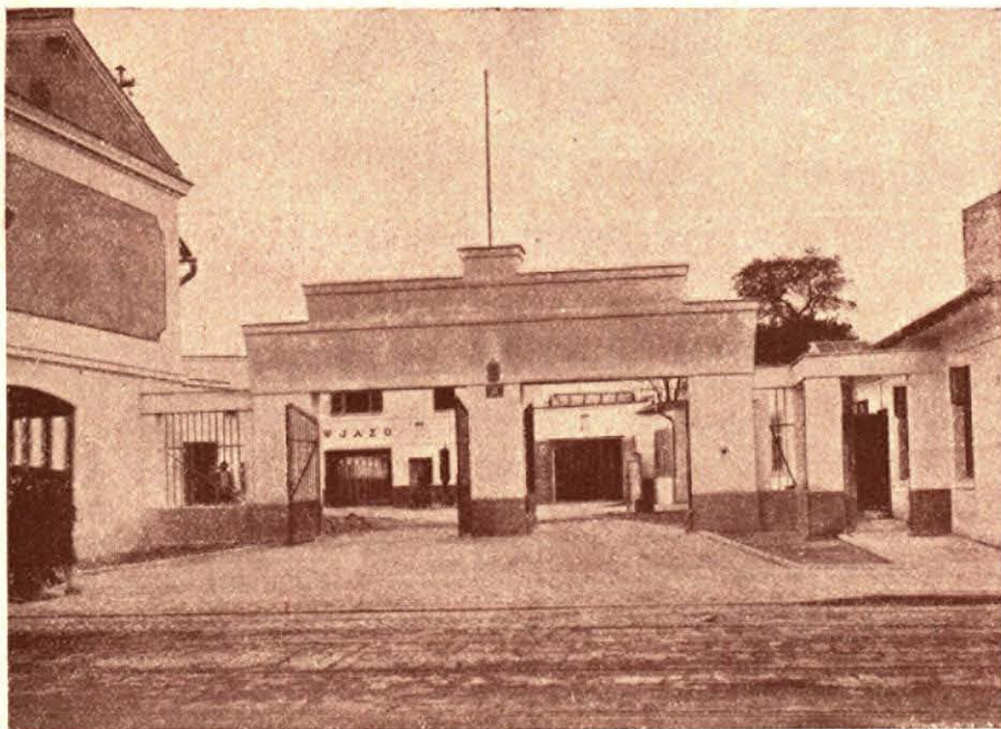
Bramy wjazdowe garażu.
