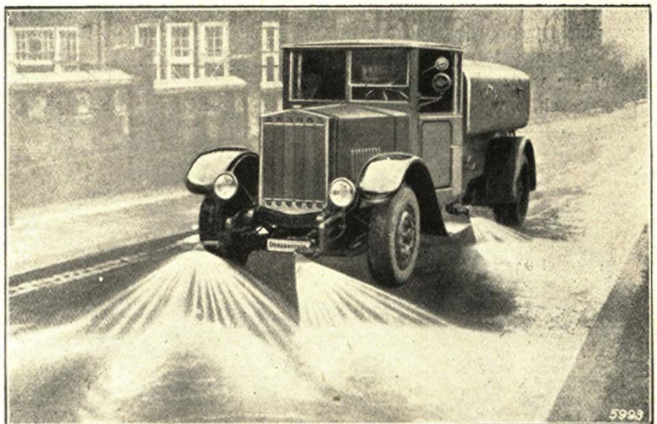
Polewaczka samochodowa Kruppa wyrzuca strumienie wody pod bardzo dużym ciśnieniem, zmiatając brud i kurz, jak szczotką.
