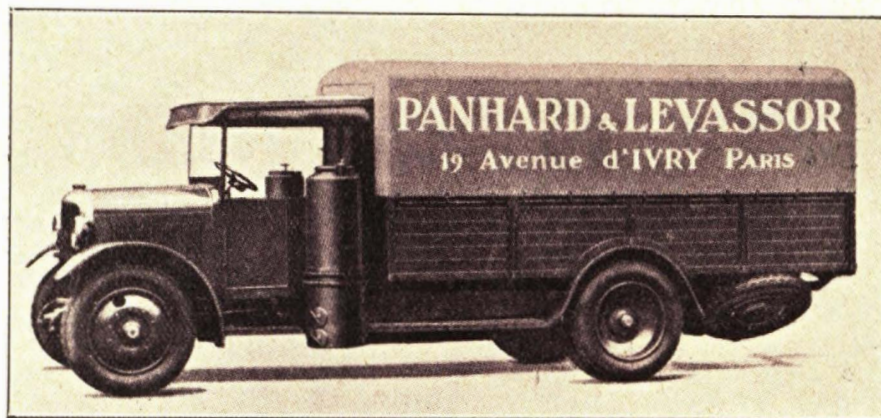
Rys. 1. Samochód ciężarowy Panhard z gazogeneratorem.
