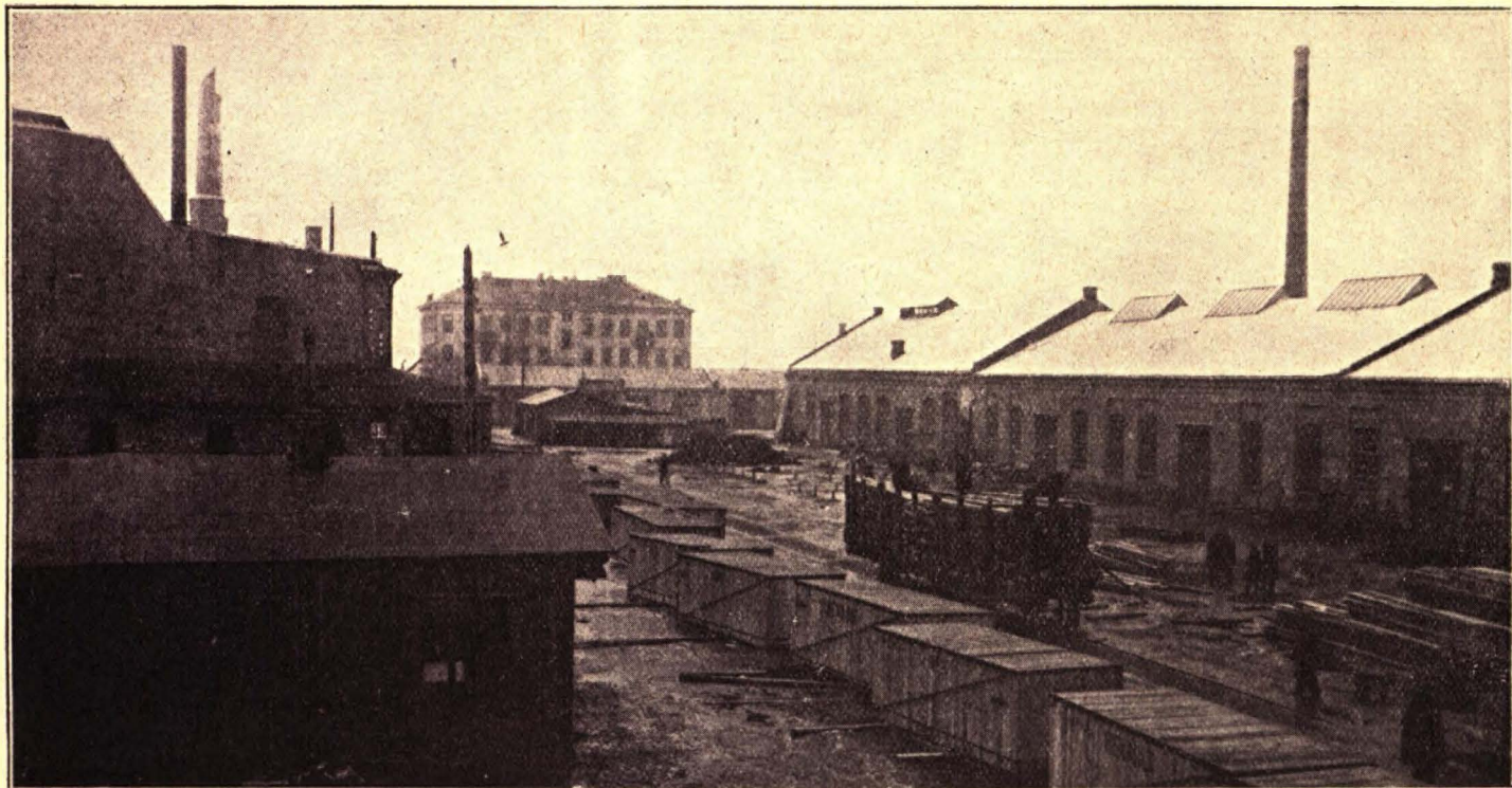
Ogólny widok części hal i zabudowań Centralnych Warsztatów Samochodowych.
