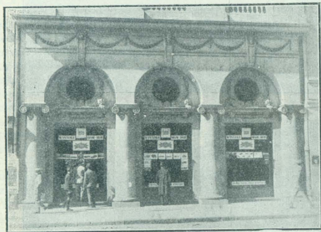
Rys. 217. Wystawa Syndykatu Handlowego w Warszawie. Widok od strony ulicy.
