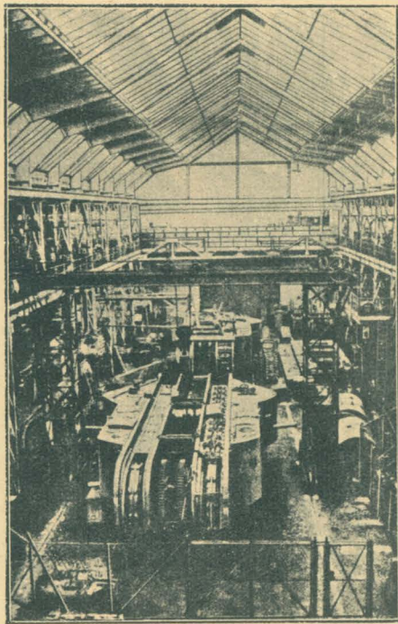
Rys. 118. Montowanie 2-ch czołgów „K. Wagen“ w niemieckich warsztatach w r. 1918.
