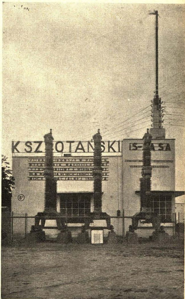
Rys. 5. Wyłącznik małoolejowy firmy Szpotański.
