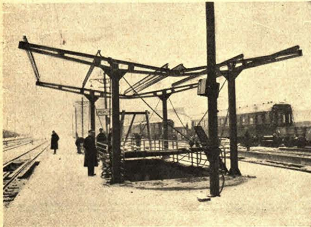
Rys. 2. Montaż wieżarów dwusłupowych.
