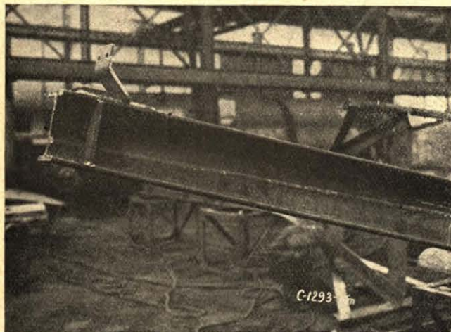
Rys. 9. Szczegół wspornika więźara jednosłupowego.
