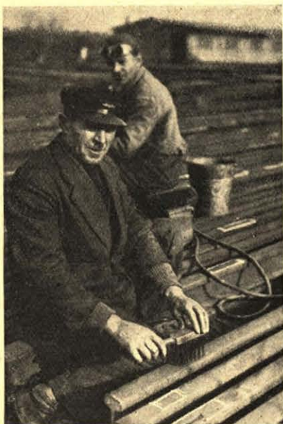
Rys. 12. Czyszczenie szyny drucianą szczotką. Na szynach widać ryski i szczybki w obwódkach z kredy.
