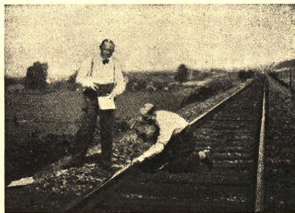
Rys. 20. Próby twardości i elastyczności napawanych szyn.
