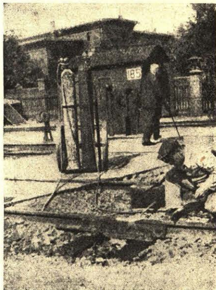
Rys. 10. Urządzenie do przewożenia i ustawiania butli przy pracy
