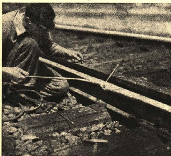
Rys. 18. Napawacz przy pracy napawania.
