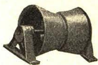
Rys. 44. Łożysko (rolka) lin ciągnącej i odciążającej.
