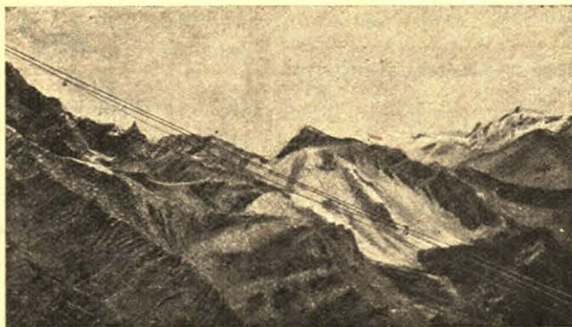
Rys. 1. Kolejka linowa w Alpach (dług. przęsła 1.350 m.).
