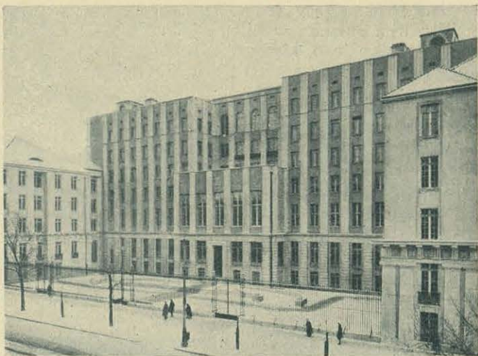
Gmach Dyrekcji Kolejowej. Widok od ul. Wileńskiej
