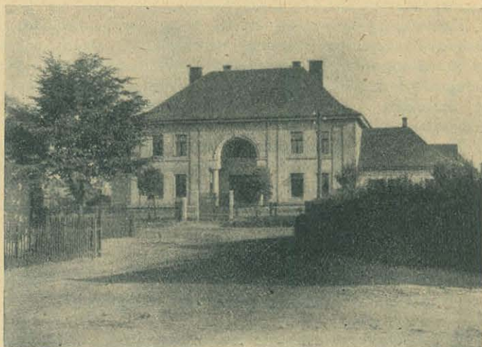
Szkola dla dzieci pracowników kolejowych w Prokocimiu.
