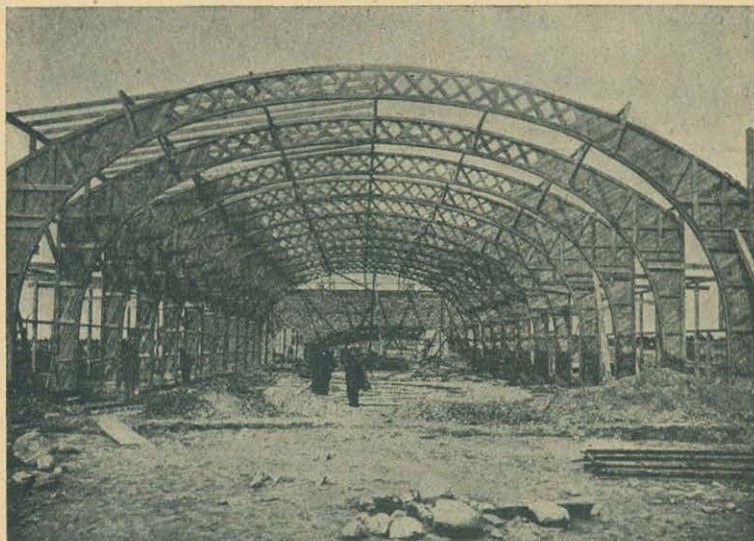
Budowa Pawilonu Przemysłu Spożywczego.
