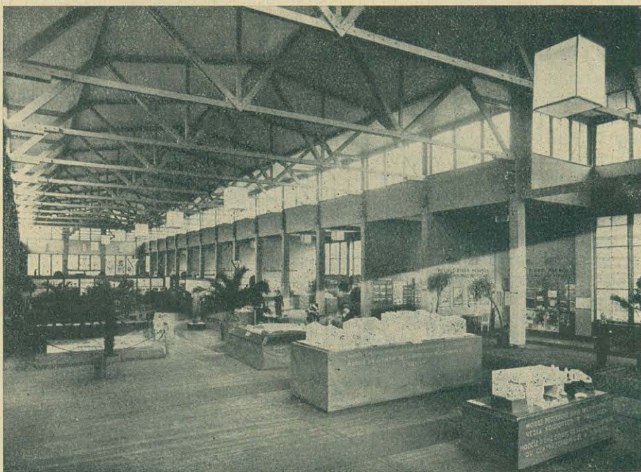
Hala wejściowa pawilonu M. K.
