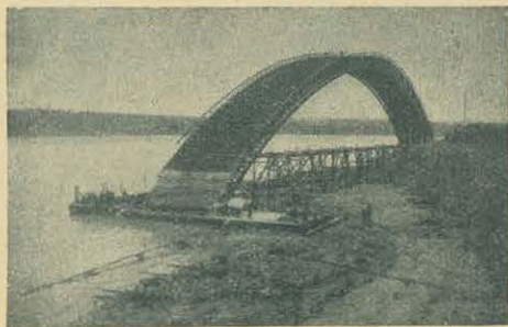
Rys. 41. Krążyny na pontonach gotowe do przesunięcia.
