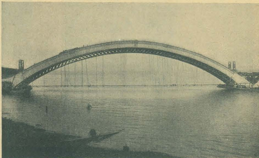
Rys. 49. Opuszczanie krążyn.
