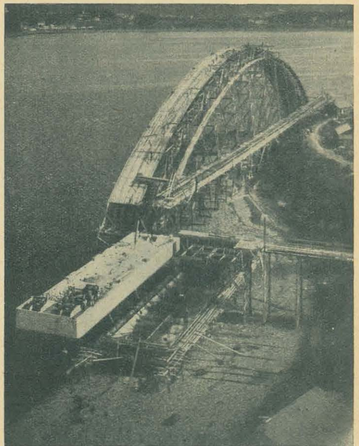
Rys. 40. Budowa krążyn i pontonów.
