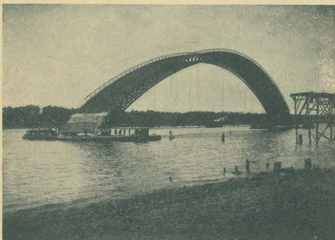
Rys. 42. Przesuwanie krążyn.
