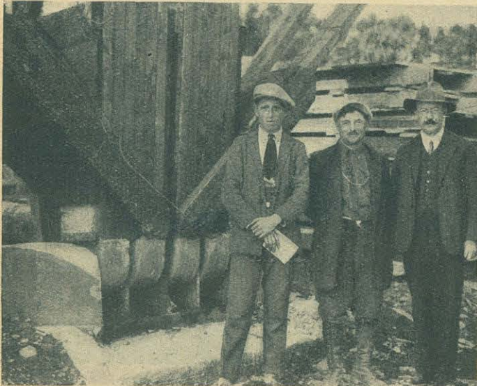
Rys. 26. Podstawa wieżycy kablowej.
