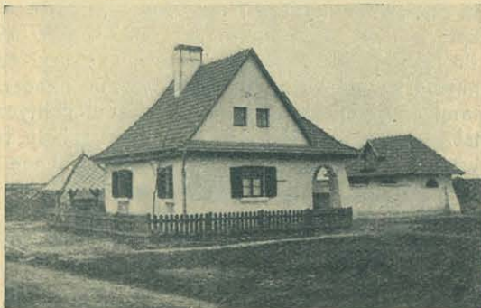
Szczęśliwice, dom torowego
