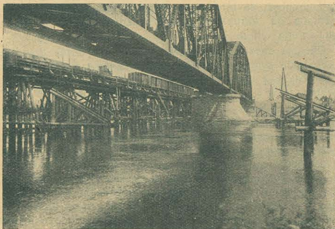
Fragment odbudowanego mostu z mostem prowizorycznym na drugim planie
