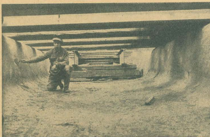
Fig. 5. Wyprawa wewnętrznych ścian murów parapetowych w części, gdzie usunięto ustrój tymczasowy z dźwigarów żelaznych i ułożono belki na murach parapetowych; na dalszym planie widać nie usunięty jeszcze ustrój dźwigarowy.
