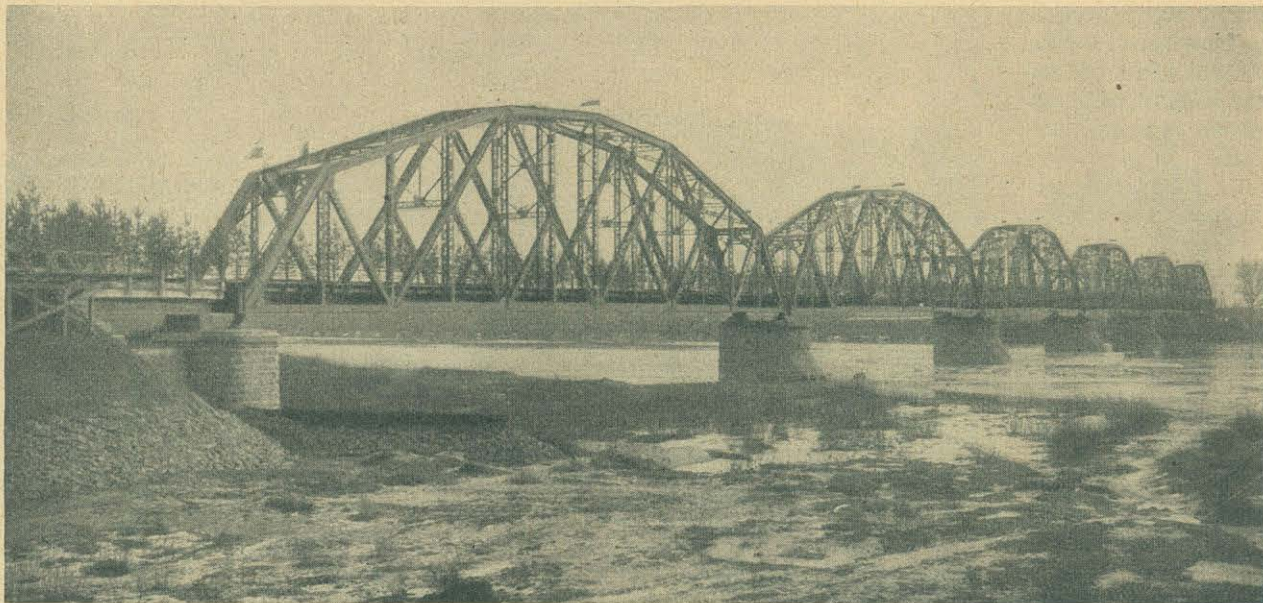
Ogólny widok mostu na Wiśle pod Sandomierzem.
