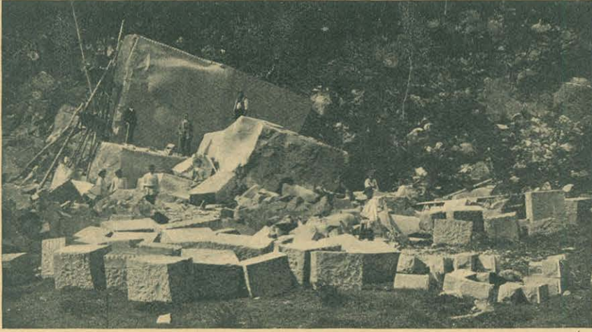
Rys. 5. Praca w kamieniołomach Polskiego Tow. Budowlanego w Jamnie.
