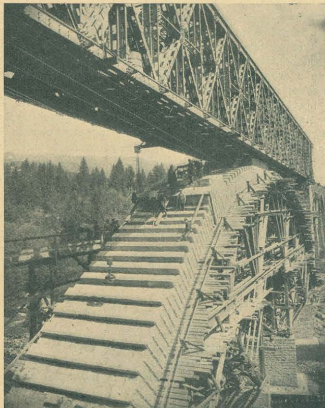
Rys. 14. Widok z góry w czasie układania ciosu III pierścienia.
