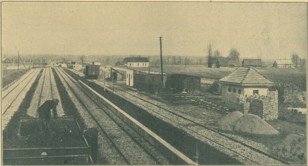
(Rys. 4). Stacja Strumień w budowie.
