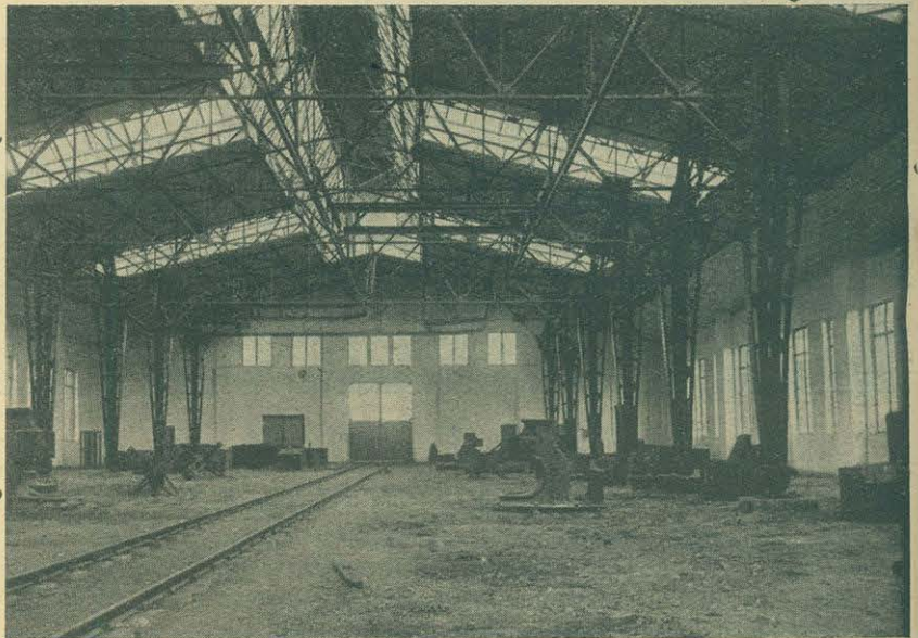
Wnętrze kuźni warsztatów wagonowych w Pruszkowie.
