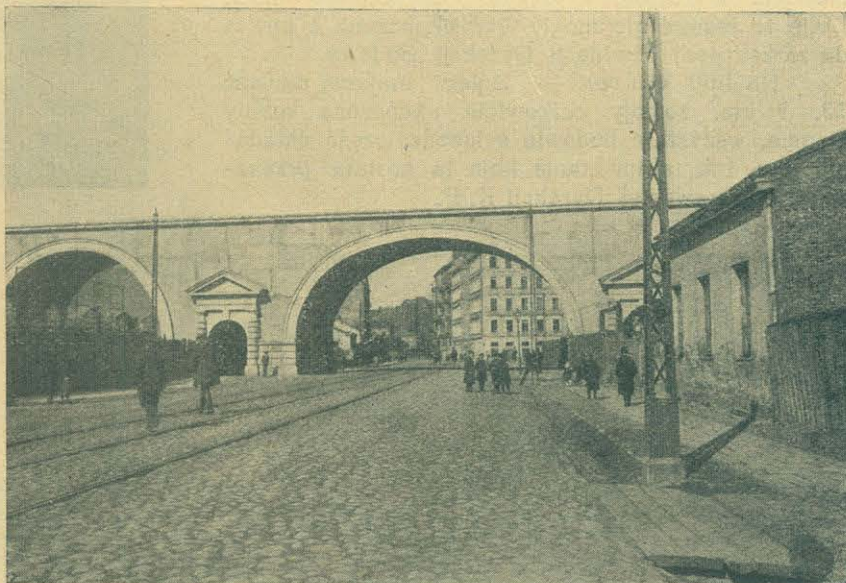
Przejście ul. Solec pod wiaduktem dł. 380 m. na Powiślu (linja średnicowa węzła warszawskiego).
