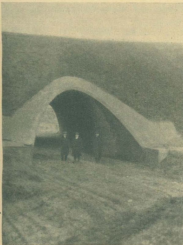
Przepust otw. 6,4 m., rzeczka Łódka pod Łodzią (linja Widzew-Zgierz).
