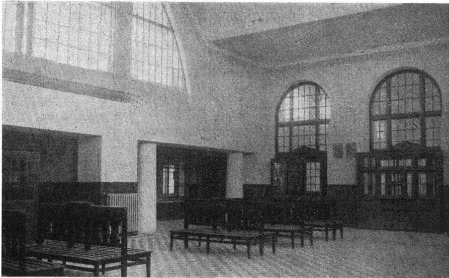
WNĘTRZE HALI DWORCA NA St. STOLPCE.
