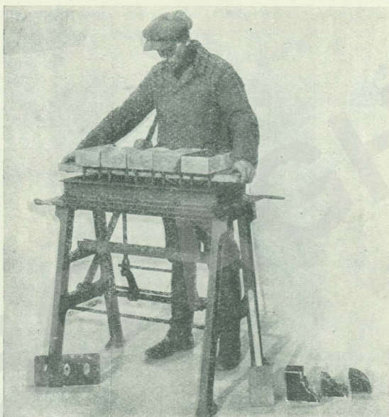
Fot. 16. Pod wysunięte ku górze cegły podkładamy deskę i odnosimy ją łącznie z ceglami na plac.
