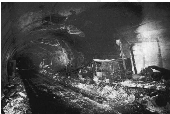
Rys. 5.5. Widok tunelu Mont Blanc po pożarze [3]
