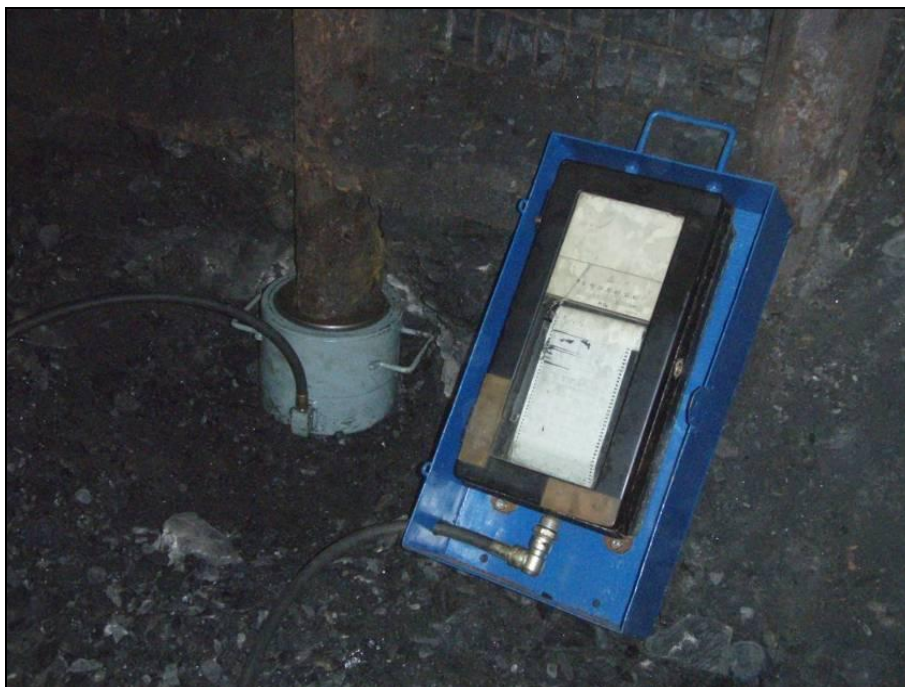
Rys. 5.22 Pomiar obciążenia łuku ociosowego przy użyciu siłownika hydraulicznego z rejestratorem.
