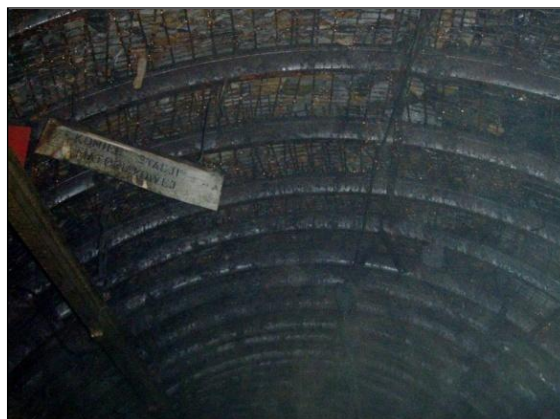
Rys. 1.3 Stateczny stan obudowy wzmocnionej z odpowiednim wyprzedzeniem.
