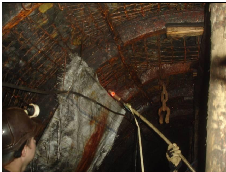
Rys. 5.18 Badanie strefy spękań stropu przy wykorzystaniu kamery introskopowej w podczerwieni.
