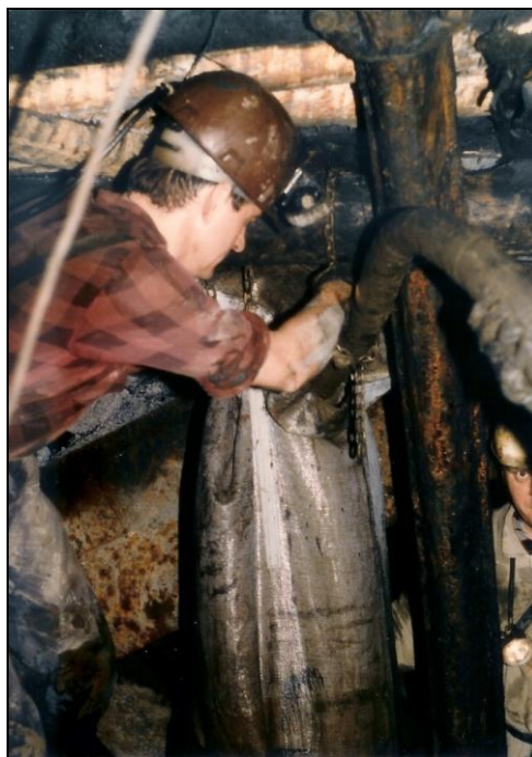
Rys. 5.12 Zatłaczanie zaprawy cementowej do podwieszonoego rękawa.
