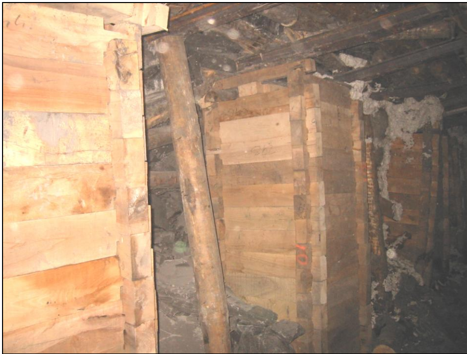
Rys. 4.19 Podpieranie stropu kasztami z drewna bukowego.
