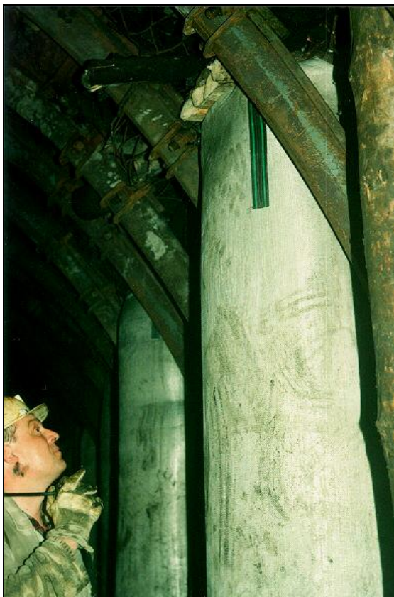
Rys. 5.8 Podparcie wspornika stropowego słupami betonowymi.
