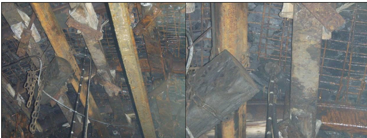
Rys. 5.20 Badania penetrometryczne stropu.
