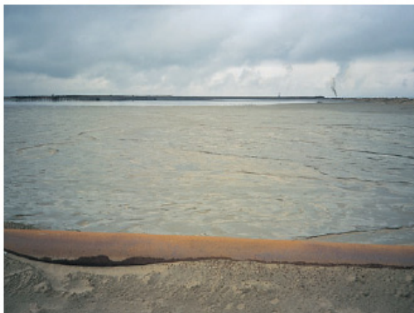
Fig. 7. Wysychające odpady poflotacyjne we wnętrzu wypiętrzonego na 25–30 m zbiornika osadowego w pobliżu Bukowna (Dmowski i in., 2002).
