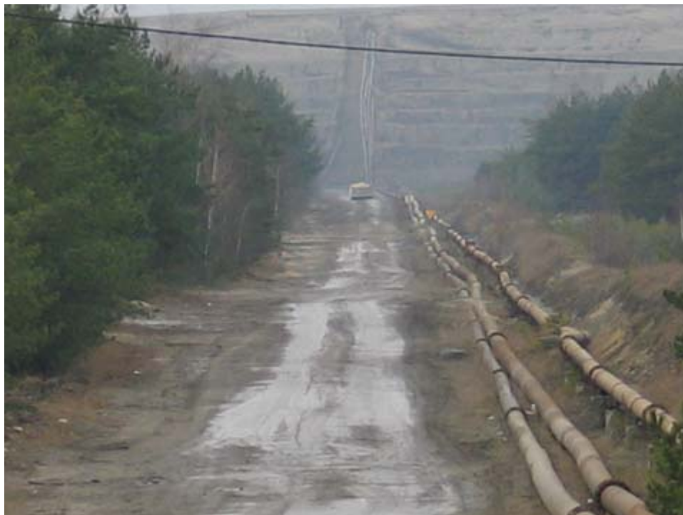
Fig. 5. Transport i składowanie odpadów poflotacyjnych na stawach (fot. B. Rajchel).
