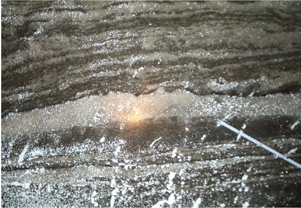
Fot. 9.2.17 Erozja stropowej części pokładu soli, ok. 100m na wschód od szybu Campi, poz. Podmoście (CV), KS Bochnia.
