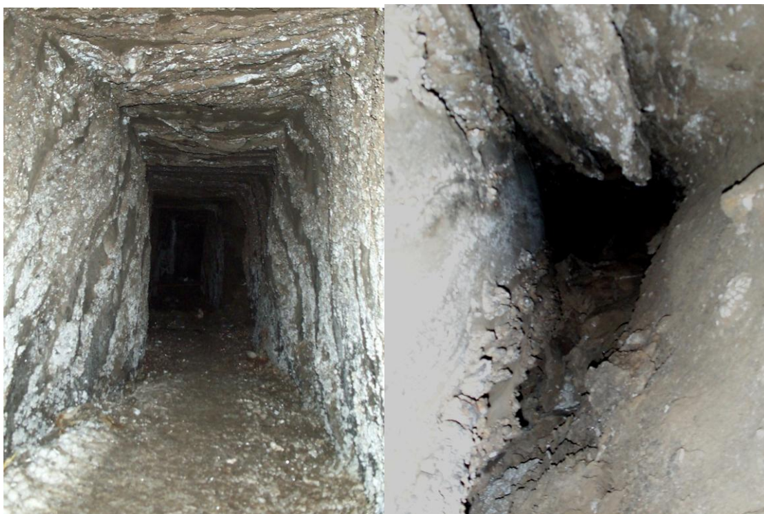
Fot. 8.1.9 Zaciśnięte wyrobisko, podłużnia August; 8 m na zachód od punktu poligonowego 3181, poz. August (CI), KS Bochnia.
