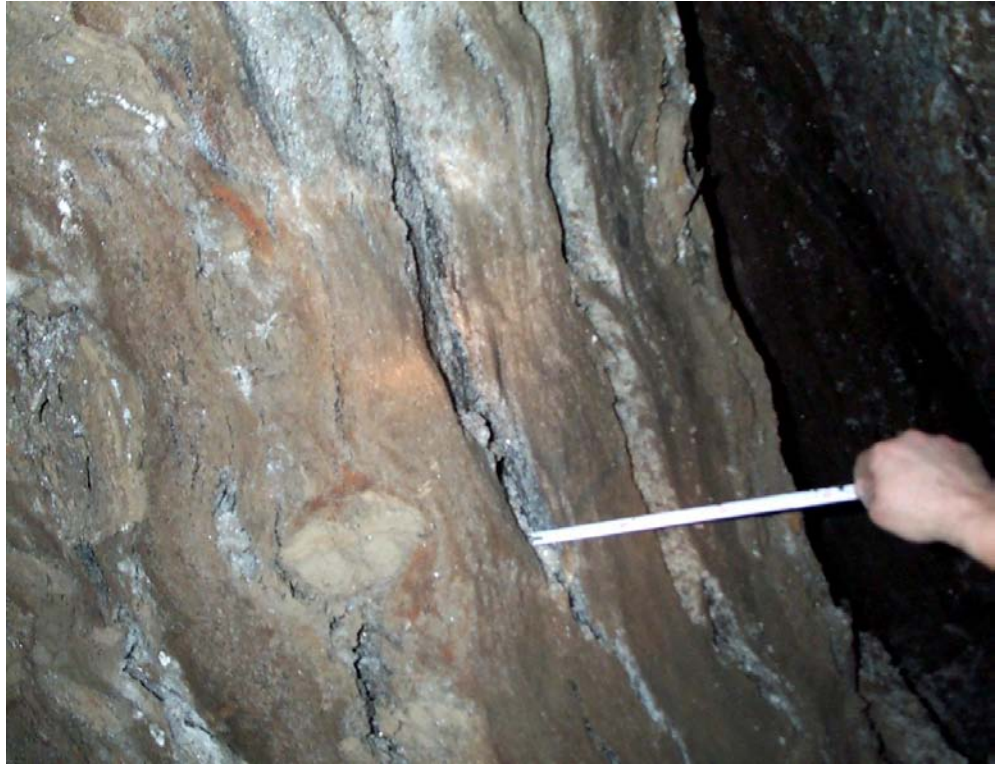
Fot. 8.1.3 Szczeliny rozwarte w rejonie podłużni Wernier, poz. Wernier (FV), KS Bochnia.
