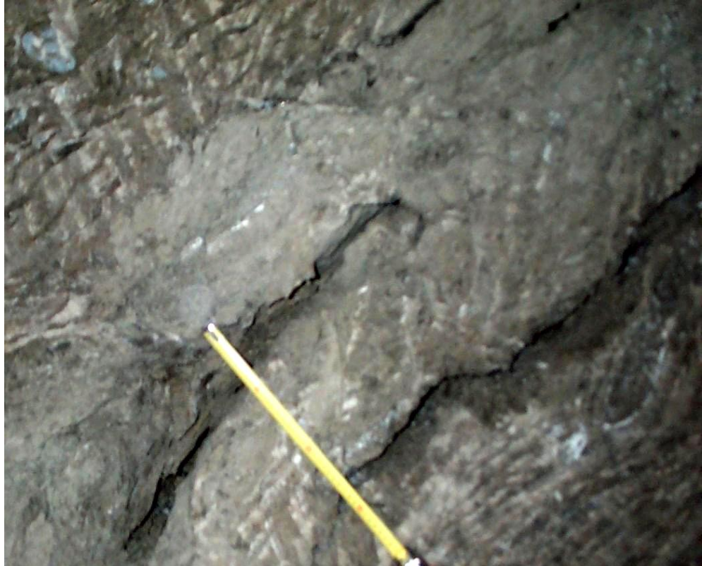
Fot. 8.1.1 Szczeliny rozwarte, wyrobisko sąsiadujące z komorą Stanetti, poz. Wernier (FV), KS Bochnia.
