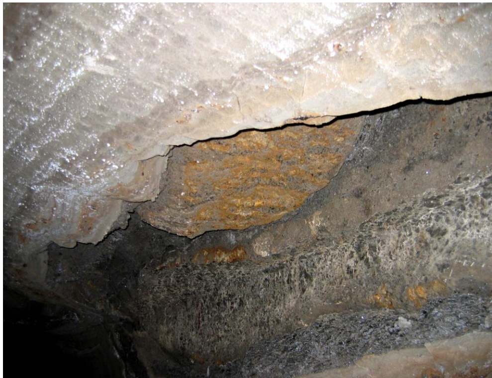
Fot. 8.1.19 Odspojenia w poprzeczni Franciszek 3; poz. A. Mickiewicza (II n), KS Wieliczka.
