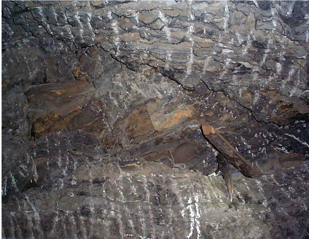
Rys. 8.1.20 Odspojenia w rejonie komory Maria Teresa, poz. J. Słowackiego (III), KS Wieliczka.
