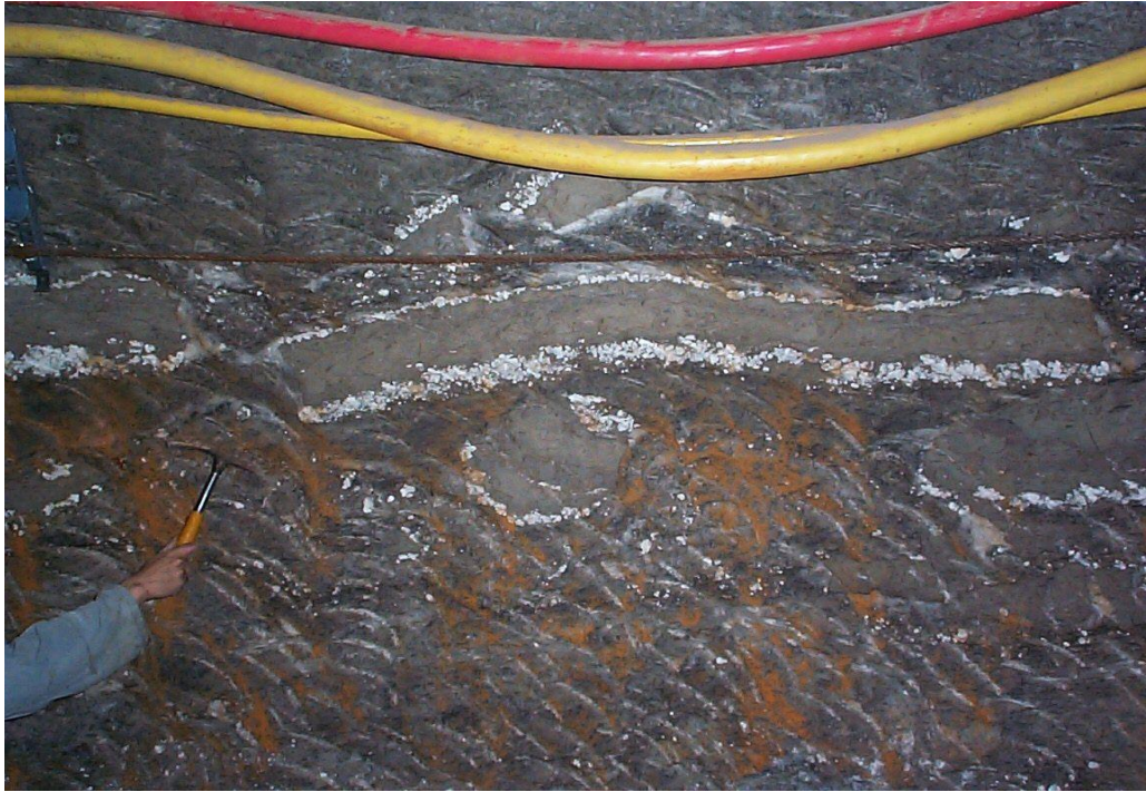
Fot. 5.4.1 Przerosty iłowe podzielone na bloki i przemieszczone, podłużnia August, poz. August (CI), K.S. Bochnia.
